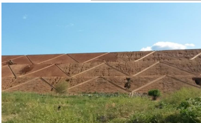
Foto 01: Vista de jusante para barragem.
