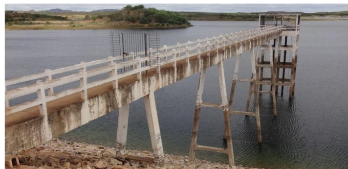
Foto 02: Torre de comando das comportas (tomada d'água) e passarela.
