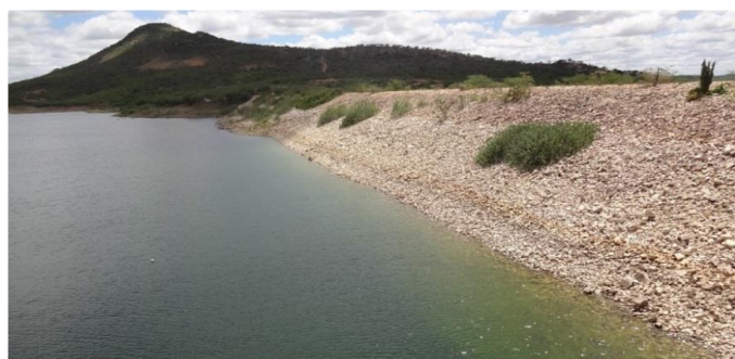
Foto 01: Detalhe do paramento de montante.
