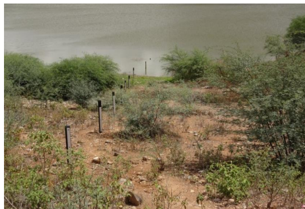
Foto 02: Conjunto de régua linimétricas.
