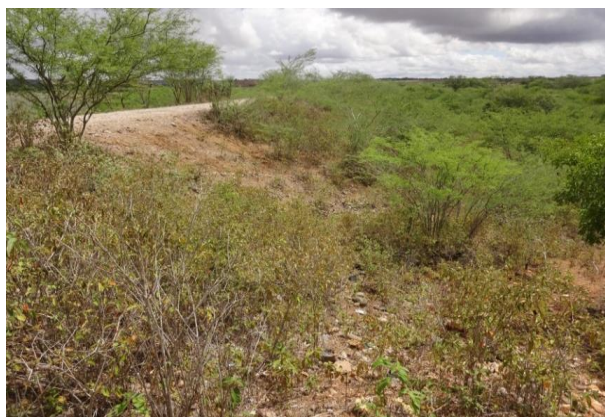
Foto 01: Paramento de jusante.
