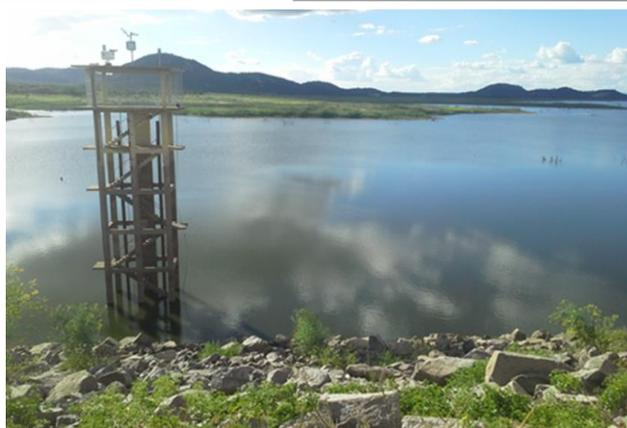
Foto 01: Torre de comando com plataforma PCD.
