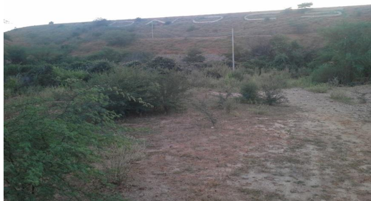
Foto 01: Vista de jusante para a barragem.
