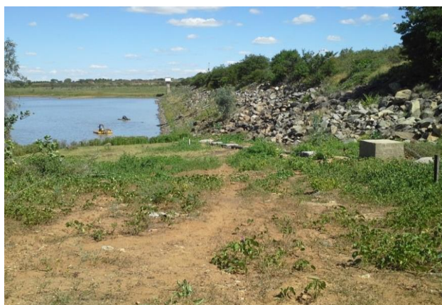
Foto 01: Paramento de montante e captação COMPESA.
