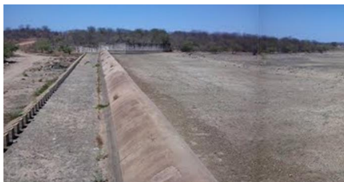
Foto 01: Vertedouro da barragem. (Fonte: Google Earth)
