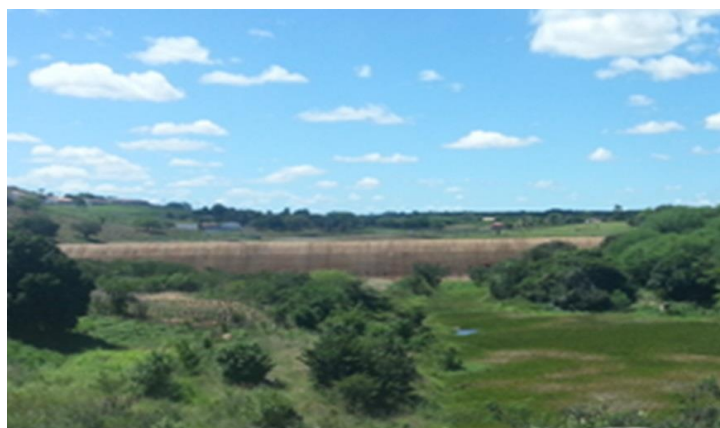
Foto 01: Vista de jusante para a barragem.
