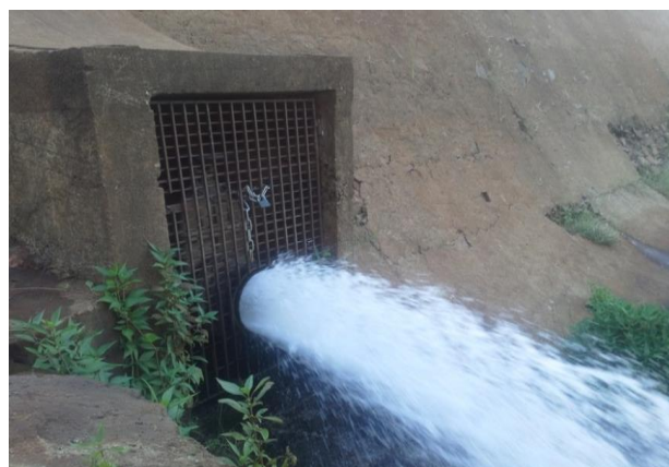
Foto 02: Tomada d'água - liberação para jusante.
