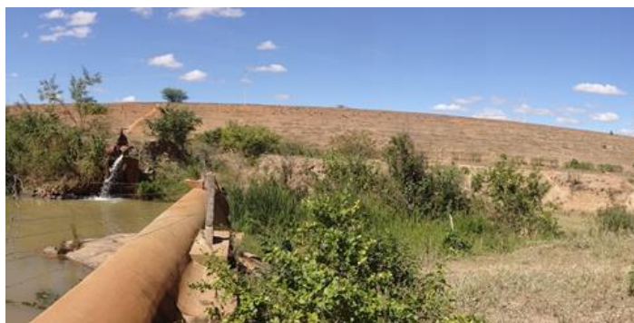
Foto 01: Vista de jusante para a barragem.
