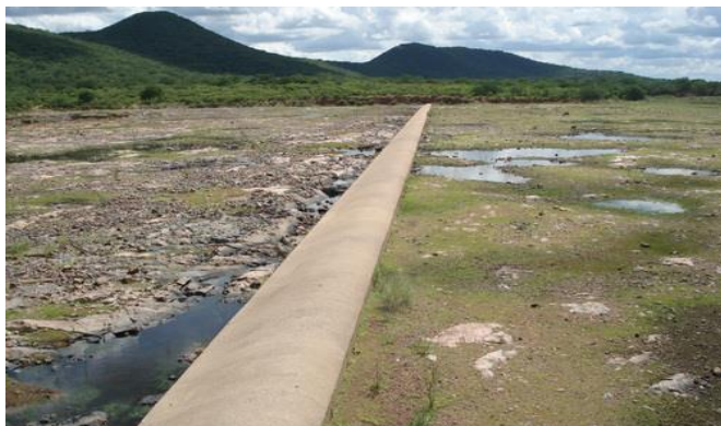
Foto 01: Vertedouro da barragem. (Fonte: Google Earth)
