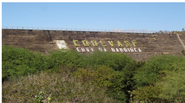
Foto 01: Detalhe do paramento de jusante.
