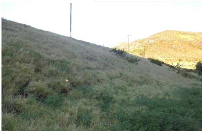
Foto 01: Paramento de jusante.
