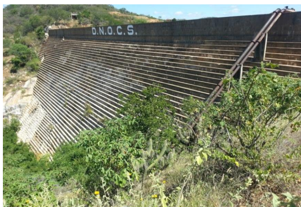
Foto 01: Detalhe do paramento de jusante.
