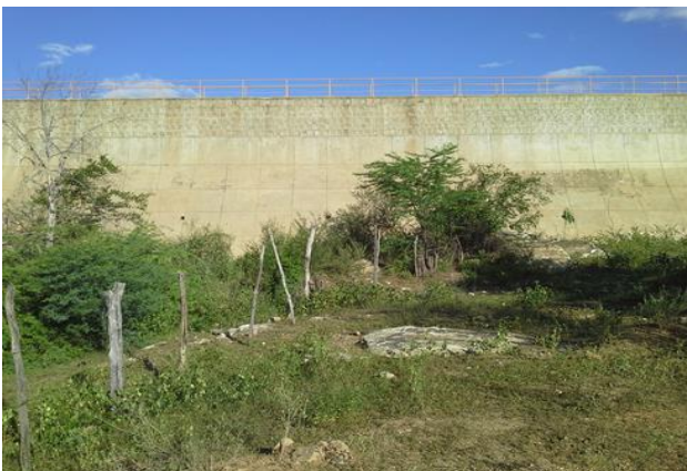
Foto 01: Vista de jusante para barragem.
