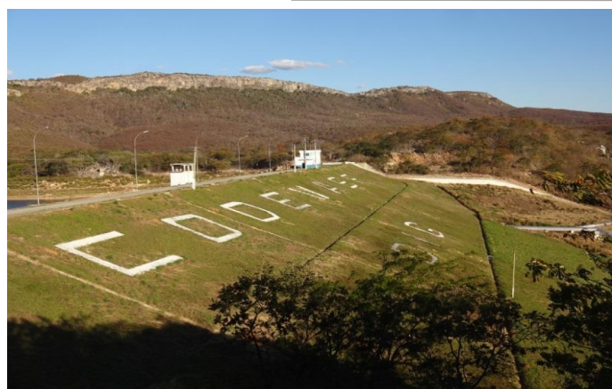
Foto 01: Paramento de montante da barragem.
