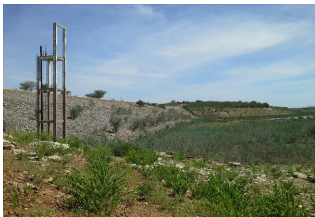
Foto 01: Vista de montante para a barragem.
