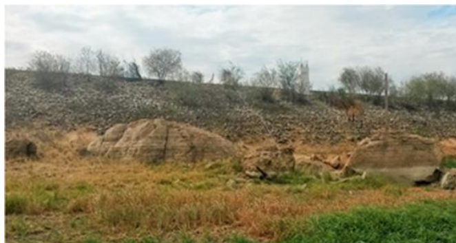
Foto 01: Vista de montante para a barragem.
