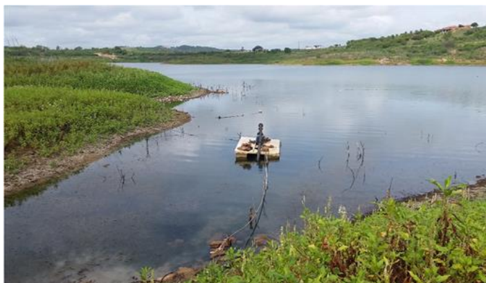
Foto 02: Bombas sobre flutuantes - abastecimento humano.
