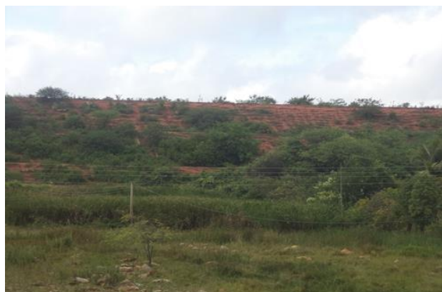
Foto 01: Vista de jusante para a barragem principal.
