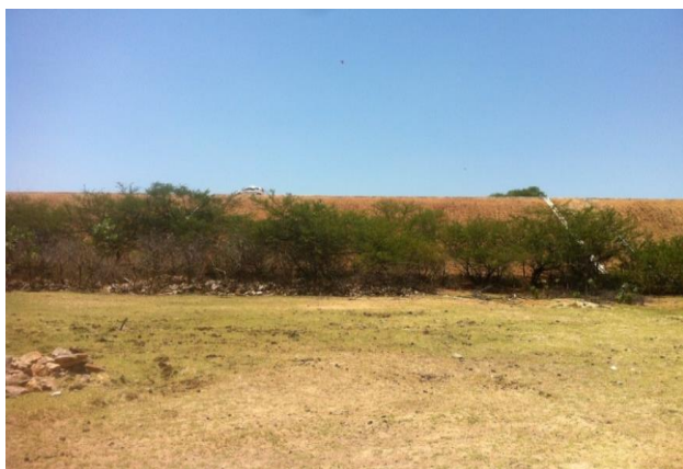
Foto 01: Vista de jusante para barragem.
