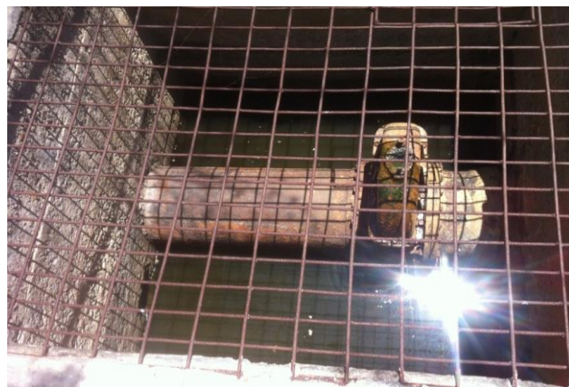
Foto 02: Tomada d'água - registro gaveta.
