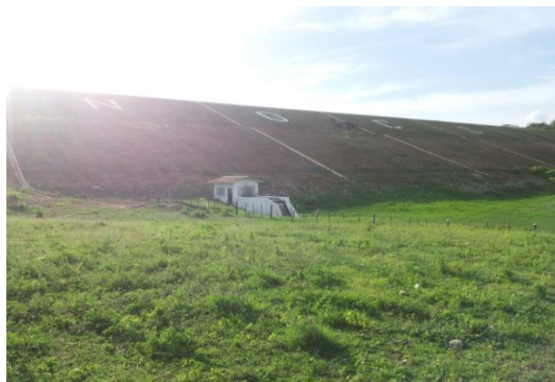
Foto 01: Paramento de jusante e caixa de dissipação.
