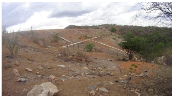
Foto 01: Vista de jusante para barragem principal.
