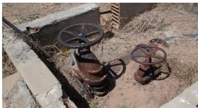
Foto 02: Tomada d'água - derivações com registros gaveta.
