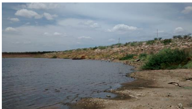
Foto 01: Vista de montante para barragem.
