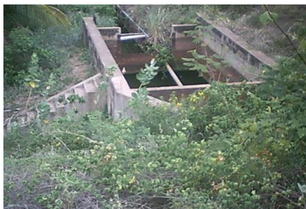
Foto 02: Tomada d'água principal - liberação para jusante.
