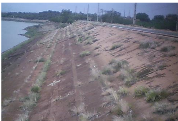
Foto 01: Detalhe do paramento de montante.
