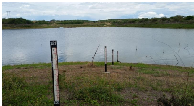
Foto 02: Conjunto de réguas do reservatório.
