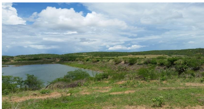
Foto 01: Vista de montante para a barragem.
