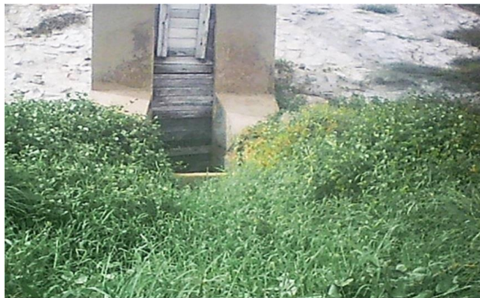
Foto 02: Galeria da tomada d'água - acesso à comporta.
