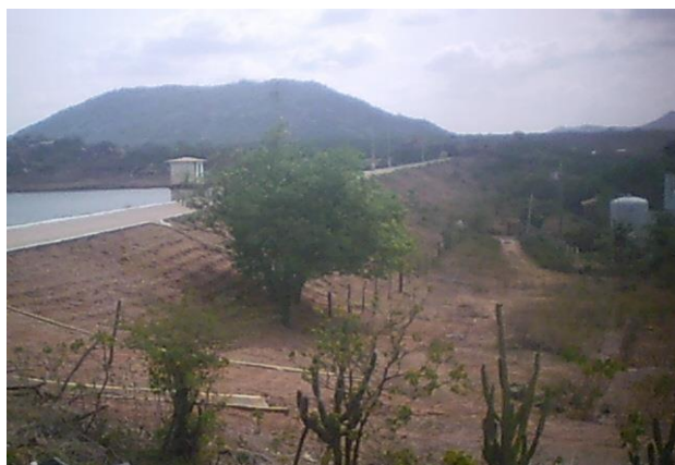
Foto 01: Vista para barragem principal.
