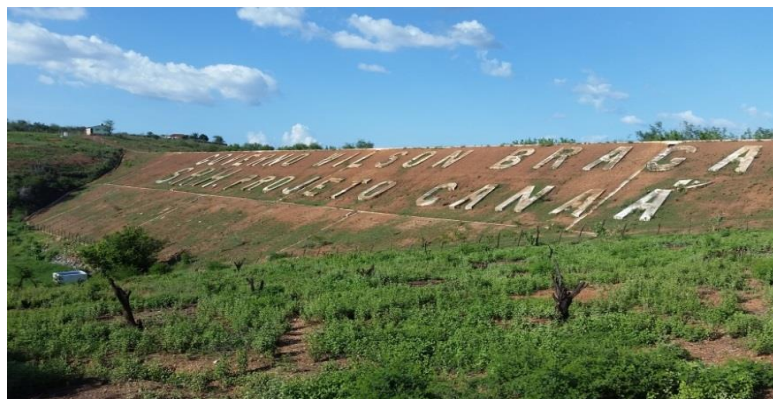
Foto 01: Vista de jusante para barragem principal.
