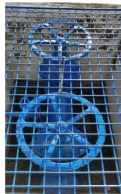
Foto 02: Liberação para jusante tubulação e registro de gaveta.
