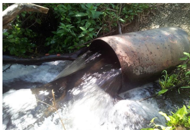
Foto 02: Tubulação de liberação para jusante.
