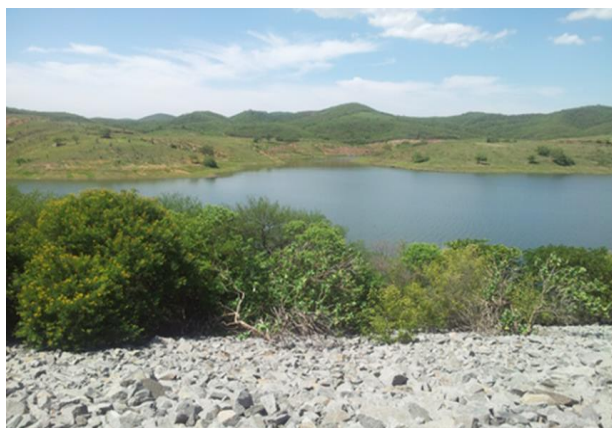
Foto 01: Vista da barragem para montante.
