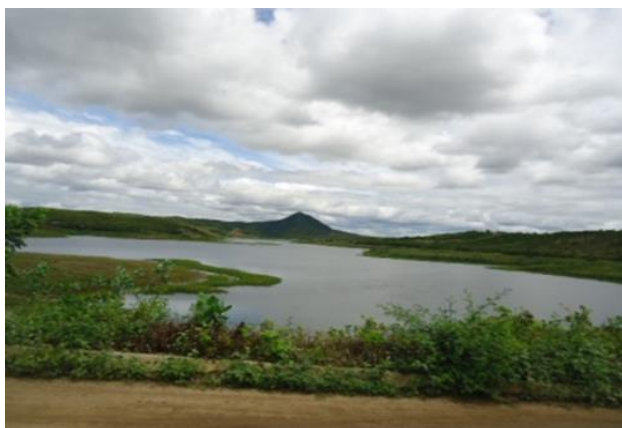
Foto 01: Vista da barragem para montante.
