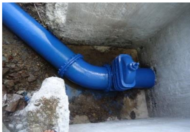
Foto 02: Tomada d'água - liberação para jusante.
