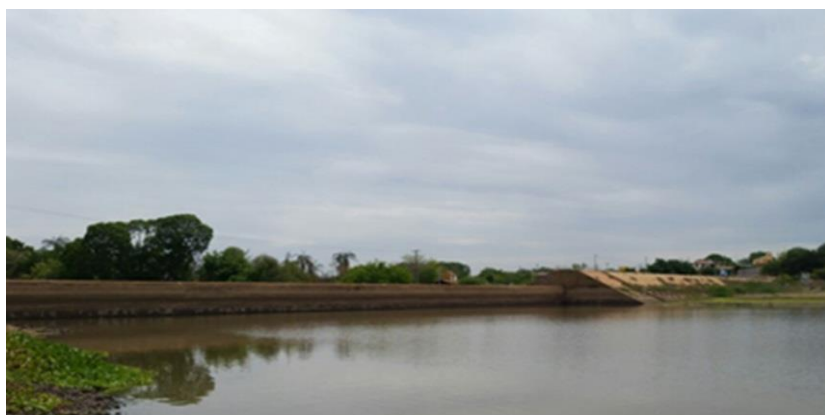
Foto 01: Vista de montante para a barragem.
