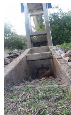
Foto 02: Detalhe da comporta da tomada d'água.
