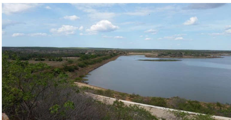
Foto 01: Vista de montante para a barragem.
