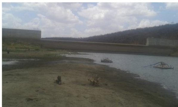
Foto 01: Vista de montante para barragem.
