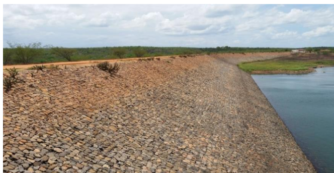
Foto 01: Detalhe do paramento de montante da barragem.
