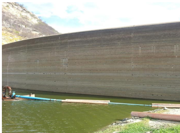
Foto 01: Detalhe do paramento de montante.
