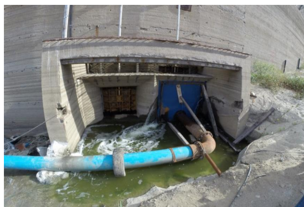
Foto 02: Tomada d'água - comporta e captação para abastecimento.
