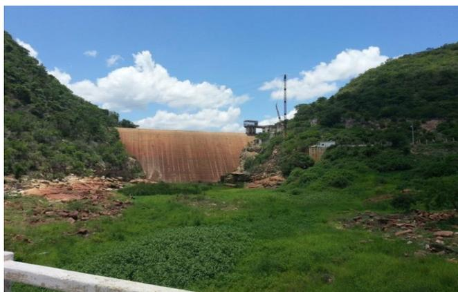
Foto 01: Barragem vertedoura, corte efetuado em rochas.
