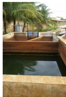
Foto 02: Tanque de medição de vazão defluente.
