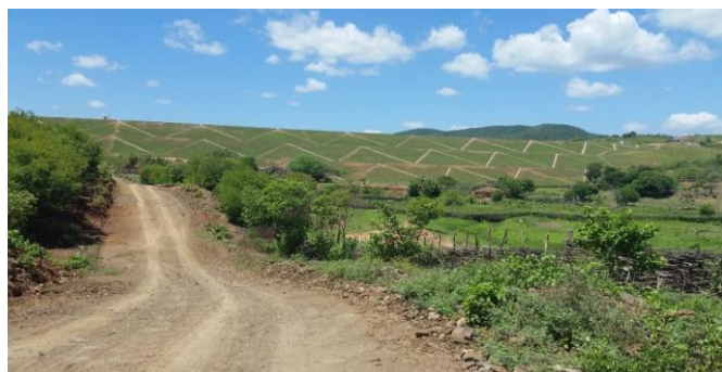
Foto 01: Vista de jusante para barragem.
