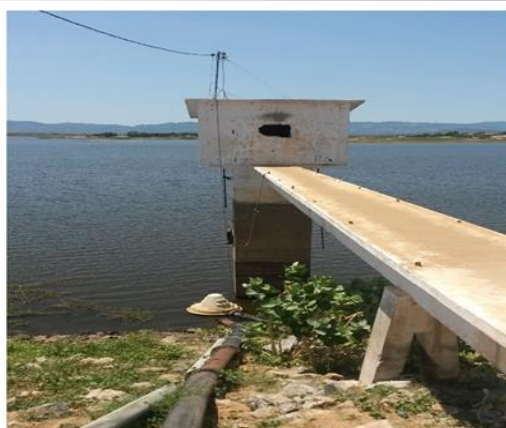
Foto 02: Torre de controle da tomada d'água.
