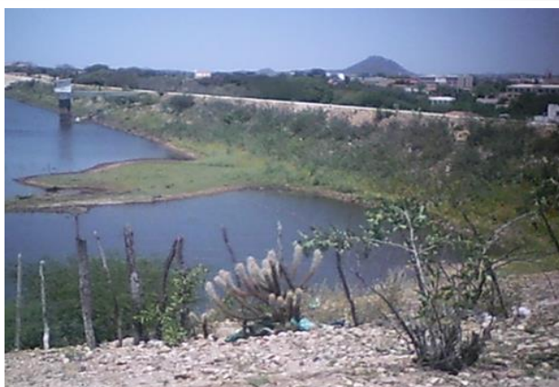
Foto 01: Vista de montante para a barragem.
