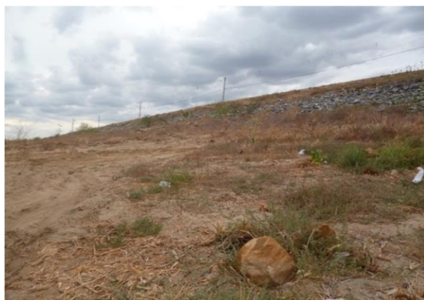
Foto 01: Detalhe do paramento de jusante.
