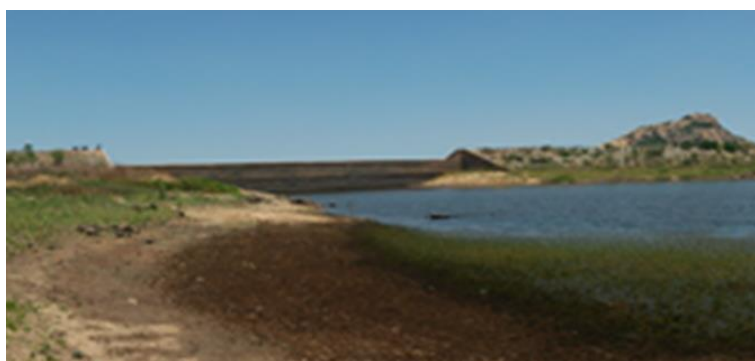
Foto 01: Vista de montante para a barragem.
