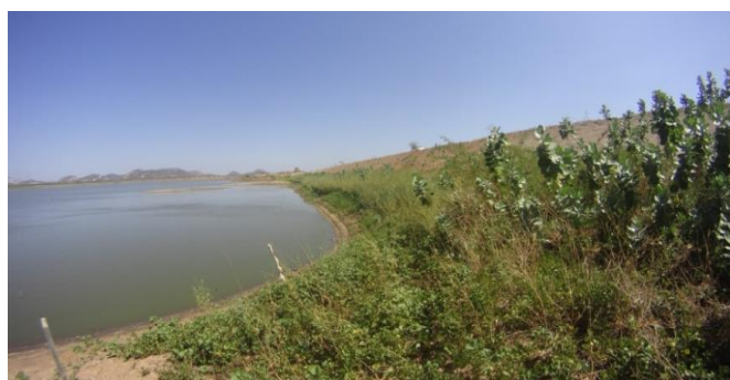
Foto 01: Vista de montante para barragem.
