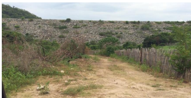
Foto 01: Vista de jusante para barragem.
