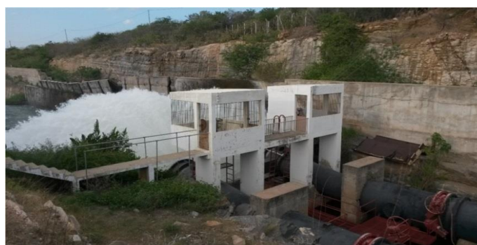
Foto 02: Comando das válvulas dispersoras.
