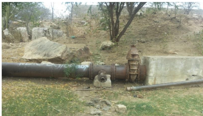
Foto 02: Tomada d'água a jusante da barragem (captação da CAERN).
