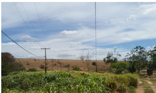
Foto 01: Vista de jusante para a barragem.
