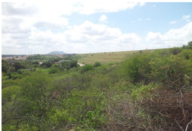
Foto 01: Vista de jusante para barragem principal.
