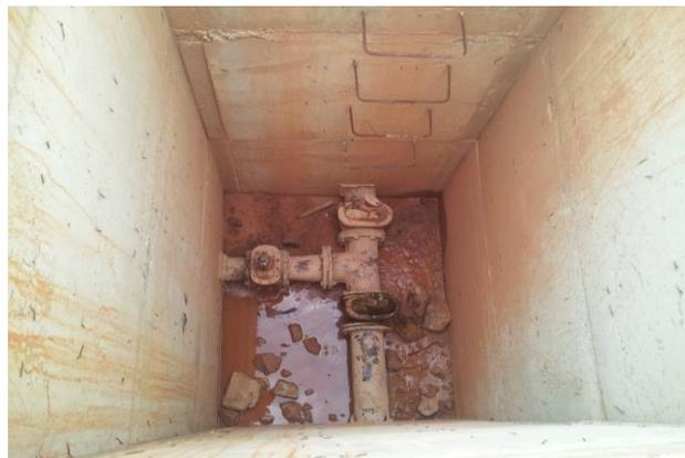
Foto 02: Registros de controle da tomada d'água do reservatório.
