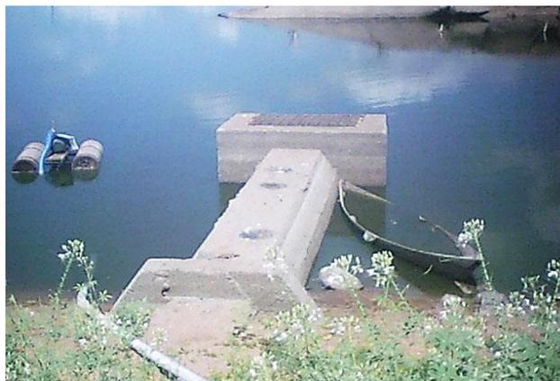
Foto 02: Tomada d'água e captação com flutuantes provisória.
