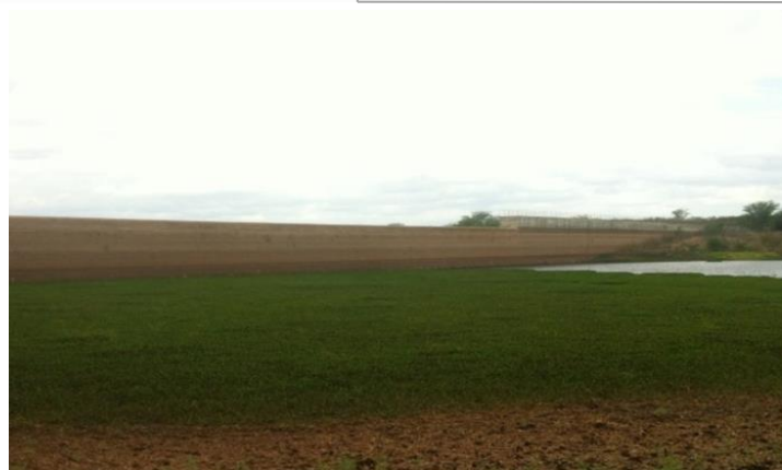
Foto 01: Vista de montante para barragem.
