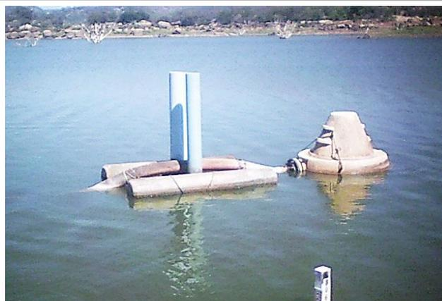
Foto 02: Tomada d'água da CAGEPA - bombas sobre flutuantes.
