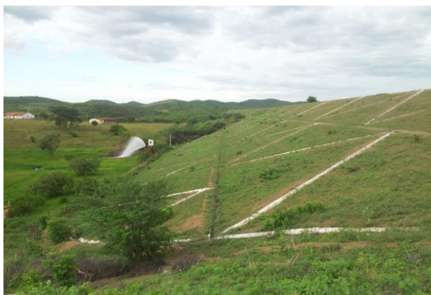
Foto 01: Detalhe do paramento de jusante.
