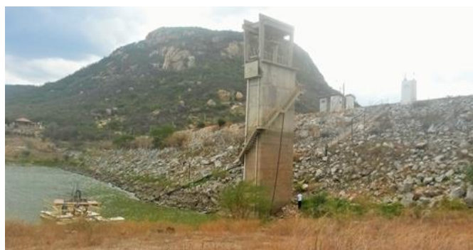
Foto 01: Paramento de montante e torre de comando.
